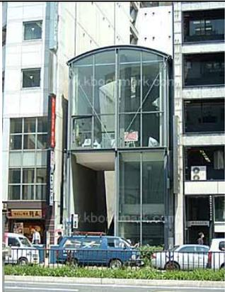
J ROOMは、昭和62年(1987)に大津通に面して建設された小規模な店舗建築です。建設当初は「M&B BLDG」という名称でした。細い間口を有効に利用し、中央部に光庭を設けた平面となつています。又、外観はコンクリート打ち放しを基調としたディテールに、開放的なガラス張りのファサードで、非常に洗練されたデザインとなっています。
