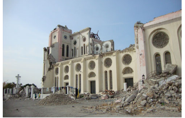
地震によって半壊した教会（ハイチ、ポルトープランス）。
